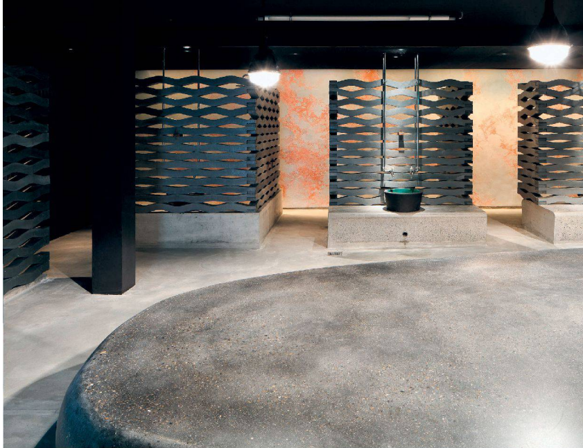
^Der Nabelstein wurde vor Ort gegossen und geschliffen.
