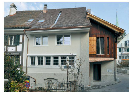
^ Die Holzschalung des Anbaus zeigt die Handschrift des Architekten.
