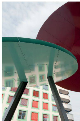
>Zweimal Dach über dem Kopf: Die Wohntürme als Haus, die Pilzköpfe als Schattenspender.
