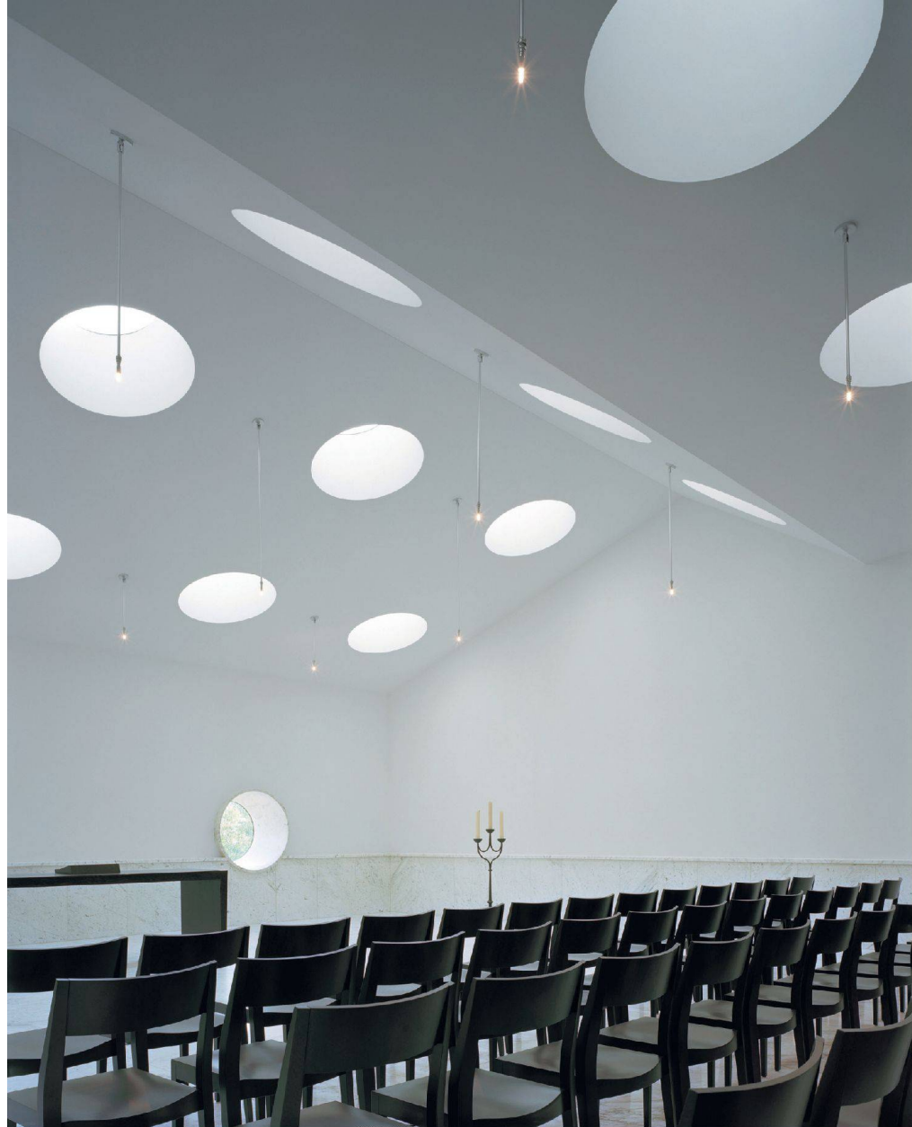
^Dach und Deckenuntersicht der Reformierten Kirche in Dornach sind unterschiedlich gefaltet – die Zylinder der Oberlichter entsprechend unterschiedlich lang.
