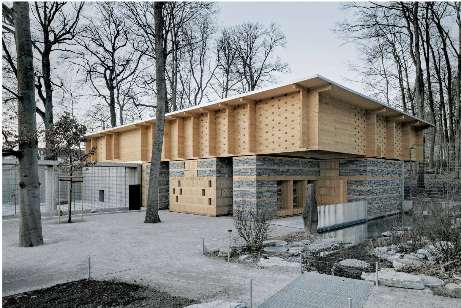
^1_Das neue Bärenwaldhaus im Berner Tierpark Dählhölzli fasst den Vorplatz und leitet zum Wald über. Vom hohen Dach spritzt das Regenwasser zu den Bären in den Teich, fließt aber auch an der Südseite durch offene Rinnen, ähnlich den Walliser Suolen, ins Biotop.
