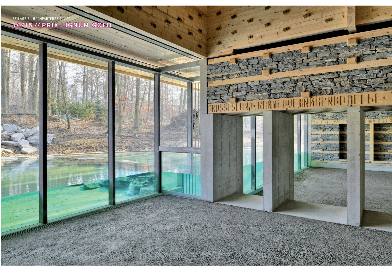
^1_Dank des vergitterten Versatzes in der Fassade sind die Bären nicht nur zu sehen, sondern auch zu hören.
