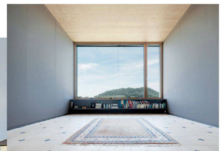
^11_ Plafonds et cadres de fenêtre sont en mélèze, les sols recouverts de carreaux marocains.
