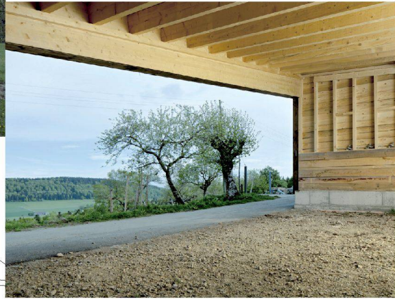
^6_ Espace réservé à la fraise à neige et aux véhicules.
