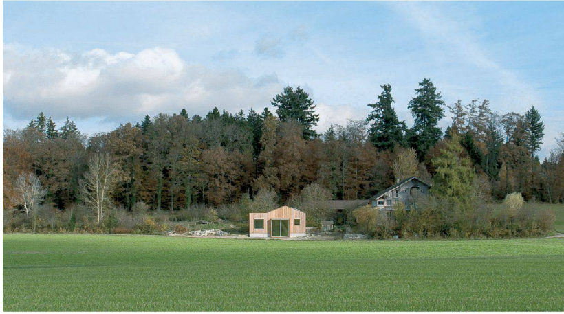
^16_Das Haus am Wald bei Hindelbank weist dasselbe Volumen auf wie der Vorgängerbau.
