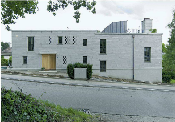
^27_ Muschelkalkblöcke prägen das Gesicht zur Strasse hin.
