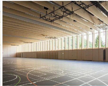
<43_Kein Windverband unterbricht den Rhythmus von Trägern und Fenstern.
