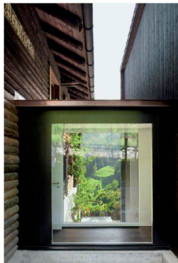
>48_ Alt und Neu sind punktuell verbunden.
