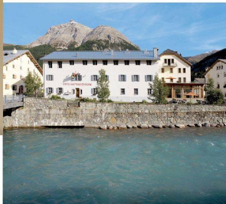
<45_Das Dach des Gasthauses Krone in La Punt Chamues-ch wurde um einen Meter angehoben. Fotos: Filippo Simonetti
