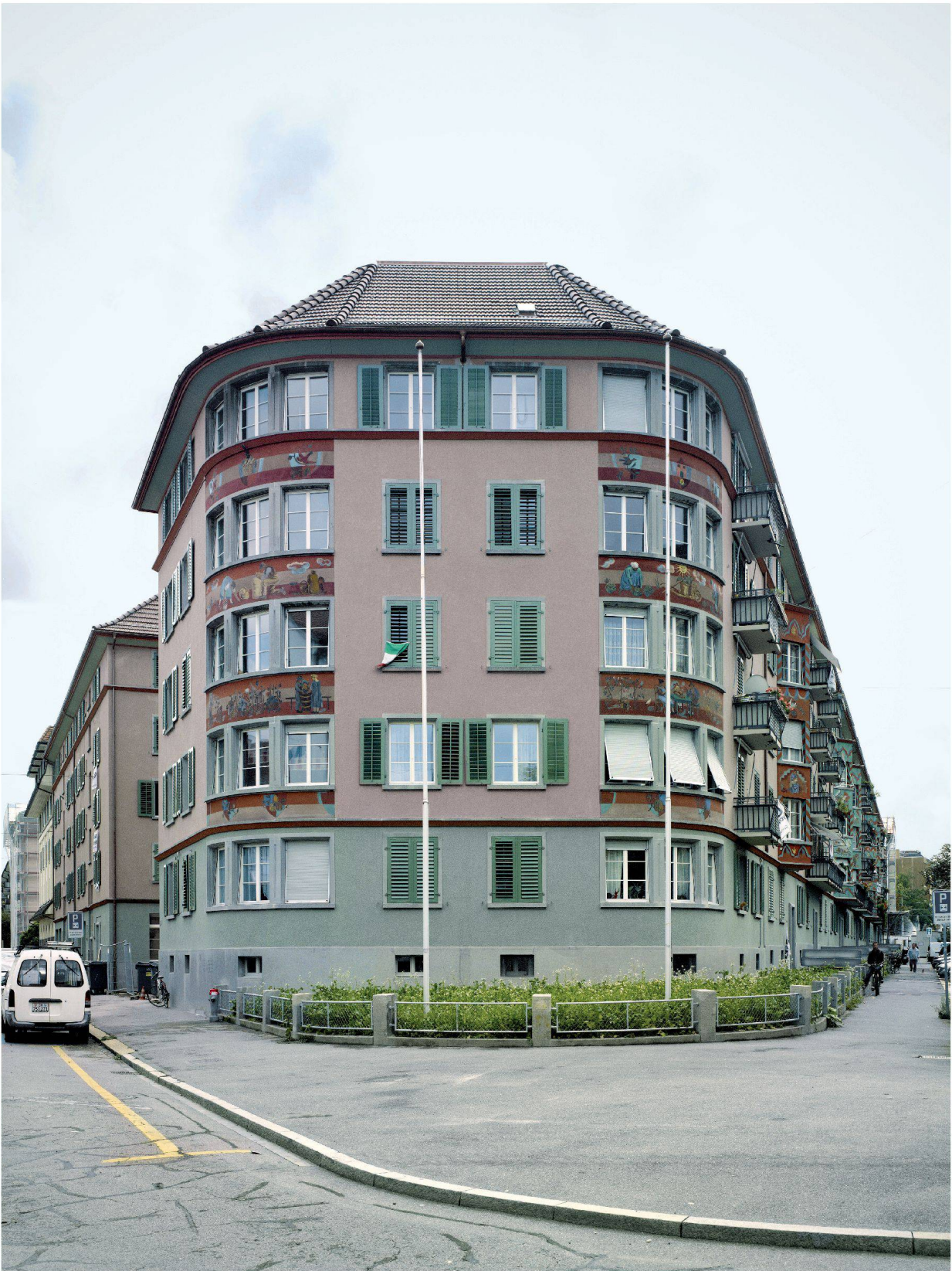
^Flaggschiff unter Denkmalpflege und mit Mieterpflege; ABZ-Siedlung Sihlfeld im Kreis 4.
