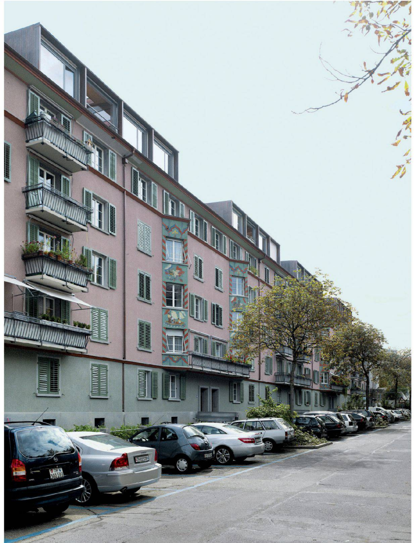
^Hauszeile an der Sihlfeldstrasse mit den neuen Dachwohnungen.
