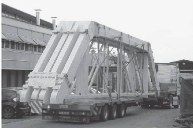
◀ Aus Platzmangel mussten alle Elemente direkt nach der Anlieferung montiert werden.
