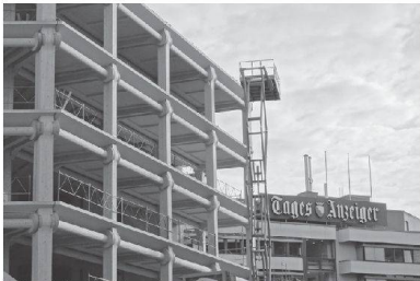
◀ Am eindrücklichsten war das Bauwerk noch ohne Glasfassade.
