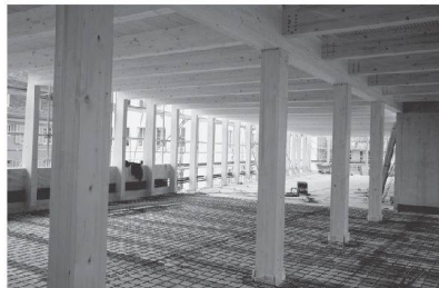
^... zusammen mit der vor Ort gegossenen Holz-Beton-Verbunddecke.
