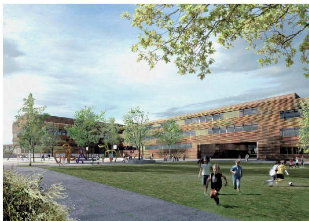
^ Schulanlage in Allschwil von Birchmeier Uhlmann Architekten und Carlos Rabinovich Architekten: Sport- und Schulgebäude sind mit einer Hülle aus Metallrohren verkleidet.
