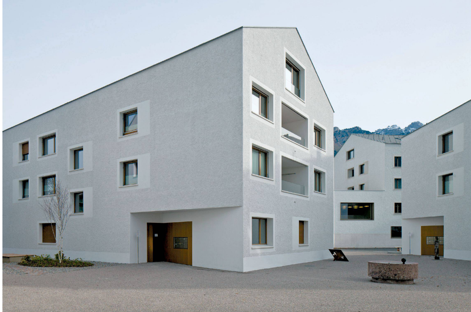
^Gekonnter Dorfbau: Lussi+Halter erzeugen zwischen den dicht stehenden Wohnhäusern eine an Perspektiven reiche Gassenwelt. Foto: Leonardo Finotti
