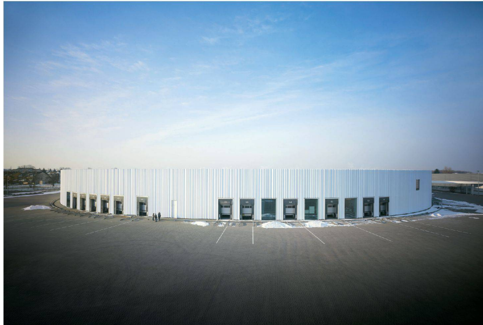
^Die runde Form täuscht: Der Neubau ist doppelt so gross wie die übrigen Industriehallen auf dem Vitra-Campus. Fotos: Julien Lanoo, © Vitra
