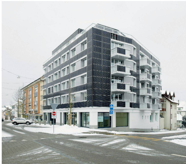
^ Die hellen Lücken an den Balkonbrüstungen werden noch mit Attrappen geschlossen.
