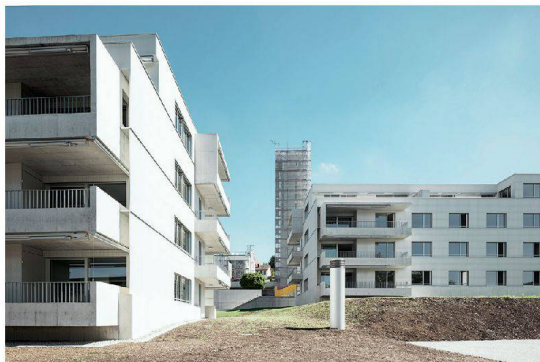
Die Wohnhäuser umschliessen auf drei Seiten den Grünraum.
