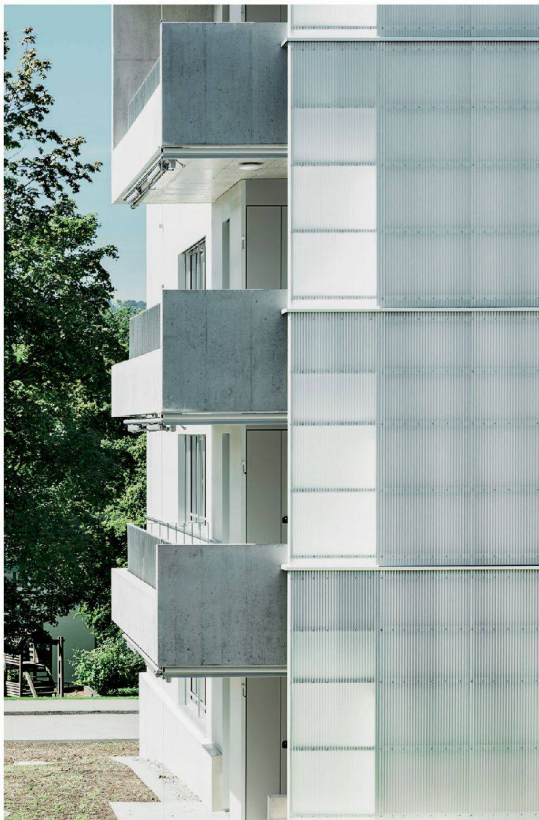
In der Wohnsiedlung Schönheim in Urdorf steht die textile Erscheinung der Verkleidung aus Scobalit in Kontrast zu den Betonteilen.
