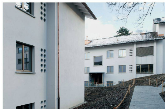
Da ein Dämmputz nachisoliert, blieben die Fassadendetails erhalten.
