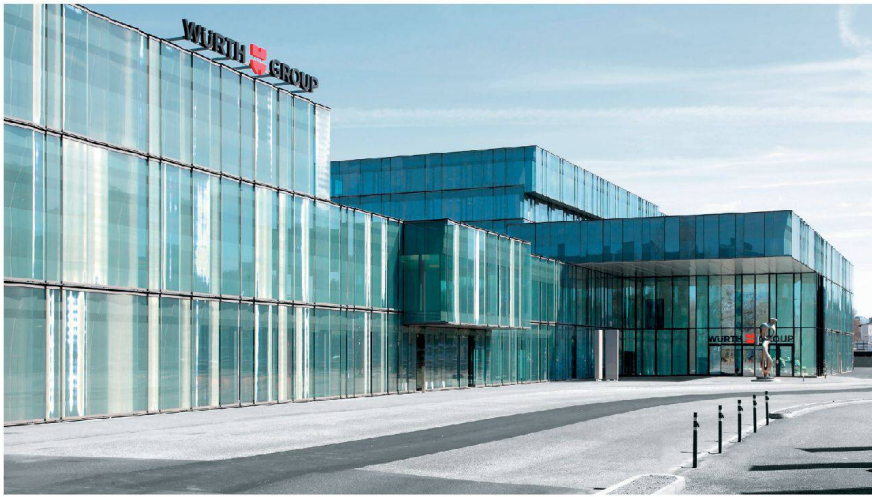
Mit einer weiten Auskragung empfängt der Neubau in Rorschach Würth-Kunden und Museumsbesucher.
