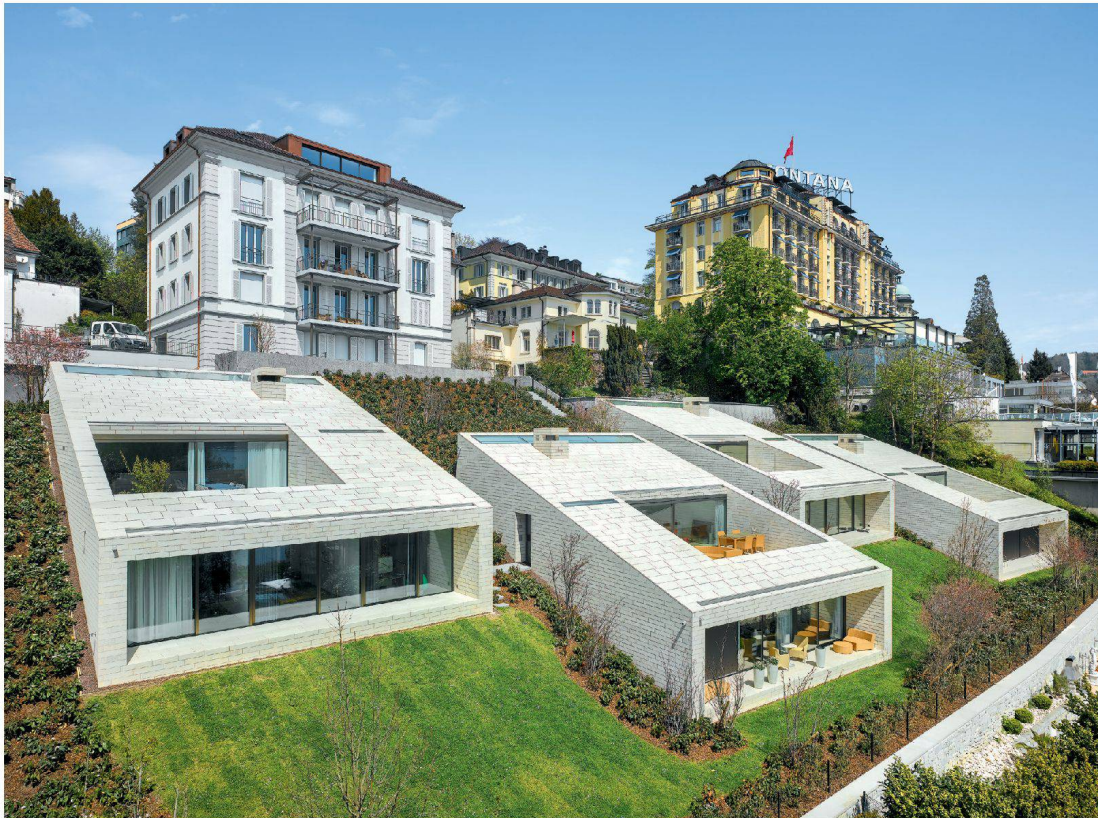
Luxusreduit: Rund die Hälfte der Wohnräume liegt unterirdisch, an die Oberfläche treten die vier Stadtvillen als weisse Schachteln.
