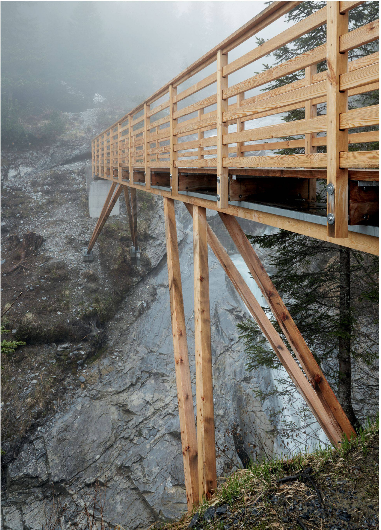
Ein filigranes Sprengwerk aus Lärchenholz dient nicht nur als Übergang, sondern auch als Ausguck in die Schlucht: die «Verweilbrücke».
