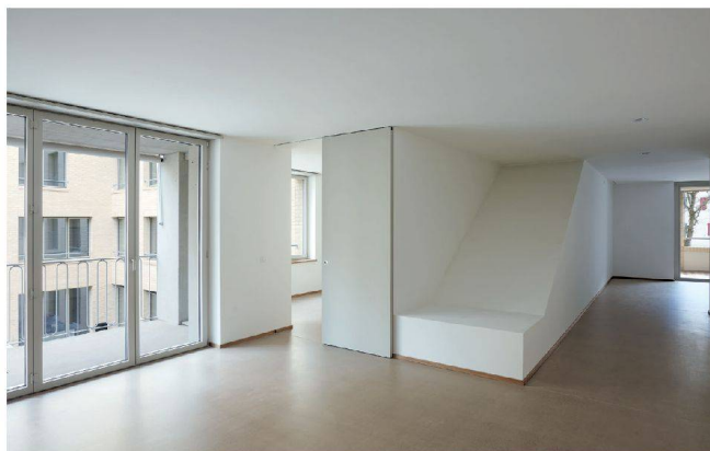
Die Treppe der Nachbarn zeichnet sich in manchen Wohnungen ab.
