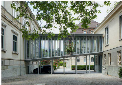
Die heitere, leichtfüssige Passerelle wird abgebrochen werden.
