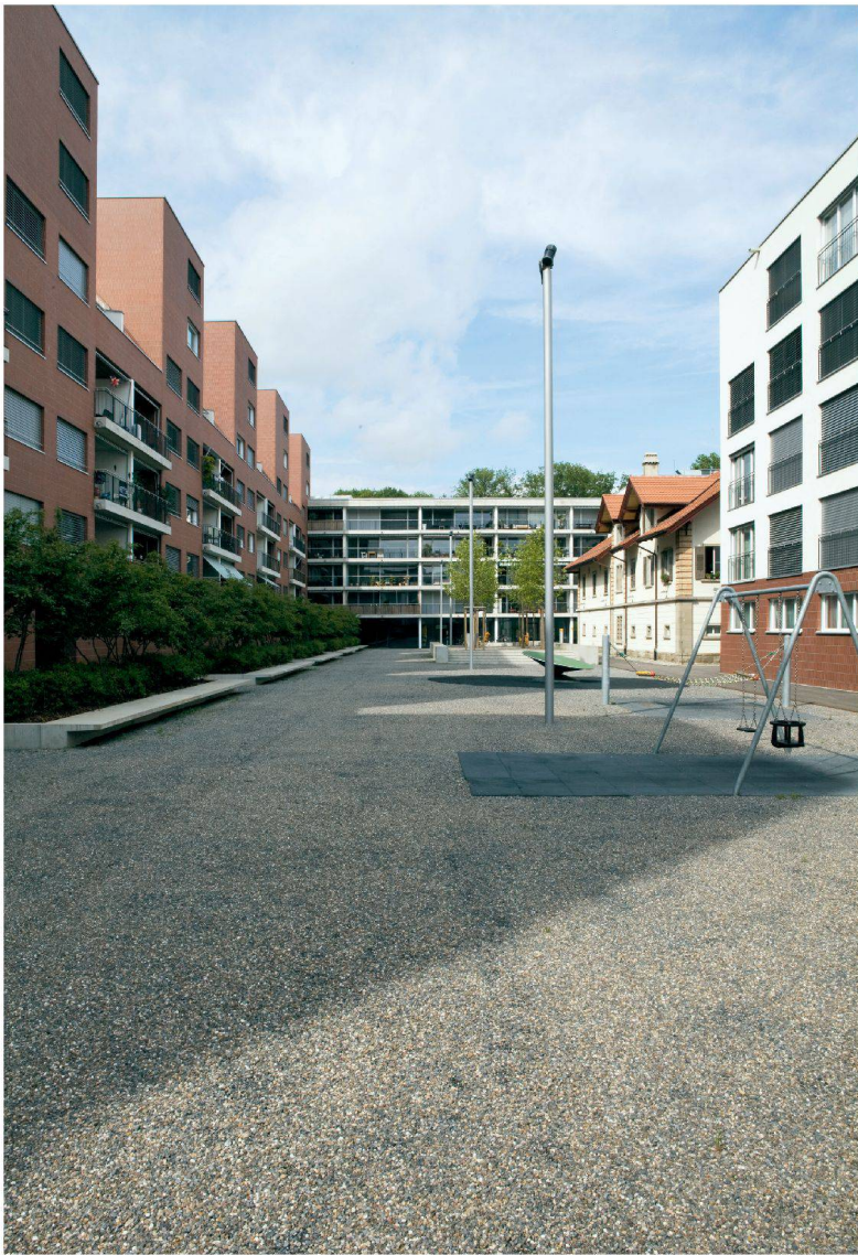
Ein urbaner Platz mitten in der Agglo: Mit der Überbauung von Spühler Partner Architekten machte das Zwicky-Areal den ersten Schritt in die Zukunft.
