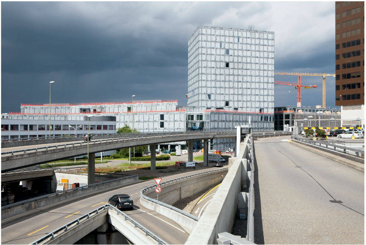
Mit dem Richti-Areal schafft Wallisellen die Verbindung von Bahnhof und Glattzentrum.
