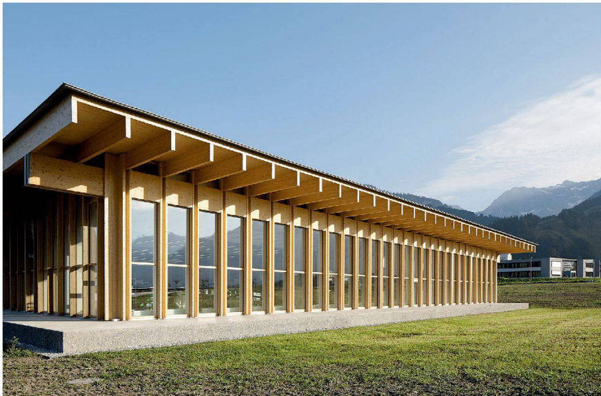
Dritter Pavillon des Maschinenbauers Trumpf in Grösch: ein lichter Holzbau auf einem Betonsockel. Foto: Ralph Feiner
