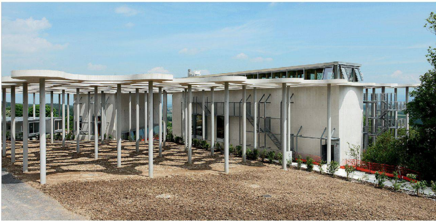
«Maison de l'Écriture» in Montricher: Unter dem Betondach sollen dereinst Hütten hängen, in denen Autoren hausen.
