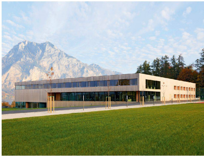
Das kompakte Volumen schont die Landschaft. | The compact volume keeps land use to a minimum.
