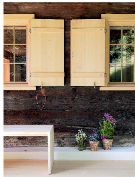
Die neuen Kastenfenster sind wie früher konstruiert. | The new windows are built the way they used to be.
