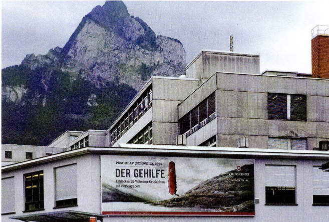
Am Fusse des Mythen: Produktions- und Bürogebäude von Victorinox in Ibach-Schwyz.
