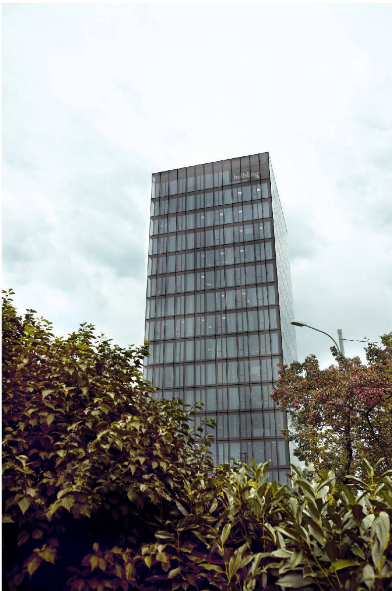
Aus dem Gebüsch steigt «Obsidian» in Altstetten und eröffnet den neuen Zürcher Hochhausreigen.
