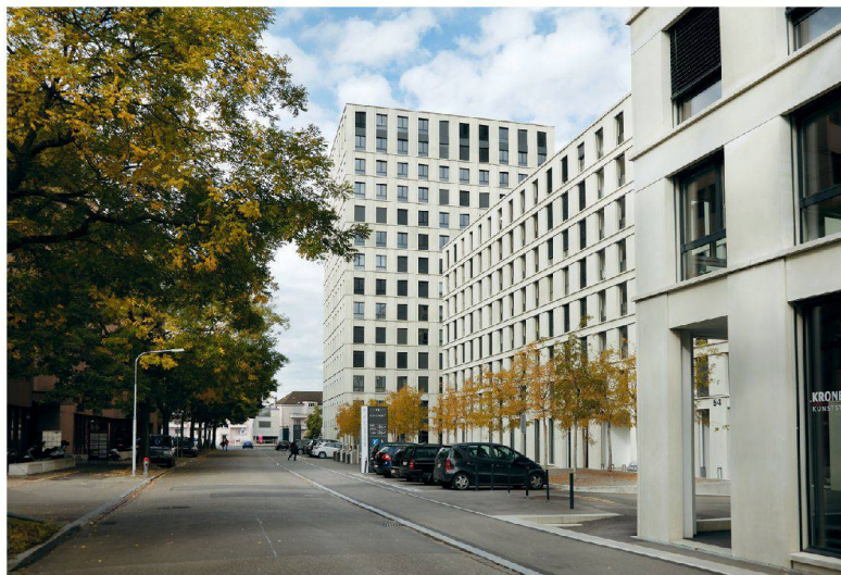
Wohn- und Geschäftshaus Connect, Zürich, 2010. Architektur: Baumschlager Eberle.
