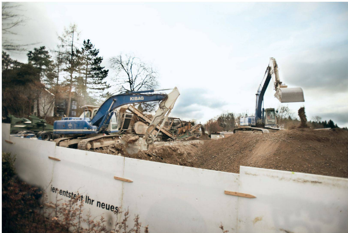
Für kurze Zeit ist der Meisenrain eine Grossbaustelle – dann stehen hier Atelier- und Reihenhäuser und verbinden Schönheiten der Moderne mit zeitgenössischer Architektur von Jakob Steib.
