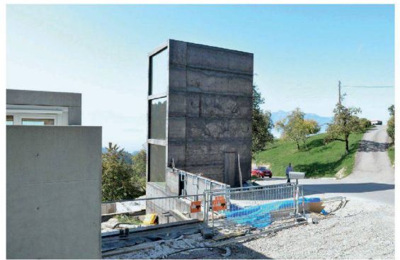
Im ländlichen Dafins (Gemeinde Zwischenwasser / Vorarlberg) ermutigt die Baubehörde zu Bauten wie diesem Wohnturm und wird dadurch zur Baukultur-Mustergemeinde.
