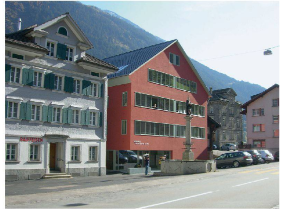
Mitten in Wassen entstanden im neu aufgebauten Rothus sechs Alterswohnungen.
