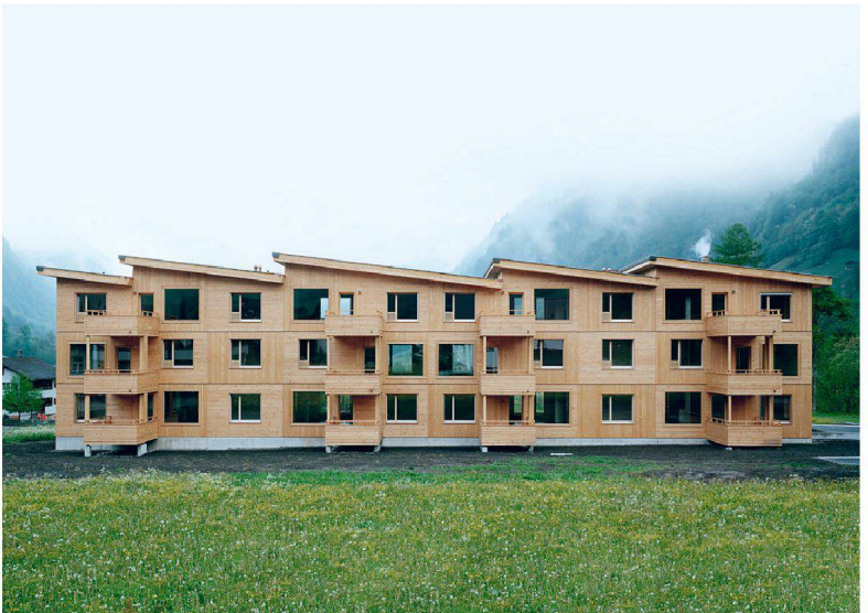
In Elm entstand 2011 ein Mehrfamilienhaus mit 12 Wohnungen (Architektur: Marti Architekten, Matt). Mancherorts fehlt noch die Erkenntnis, dass es solche mutigen Beispiele braucht, um Baukultur zu schaffen. Foto: Rasmus Norlander
