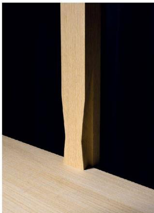
Wie ein Schwalbenschwanz gefügt.
