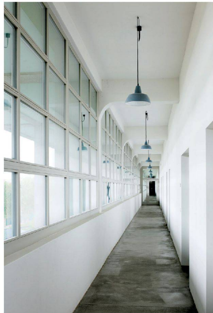
Im 2. Obergeschoss liegt der Laubengang im Inneren des Gebäudes.
