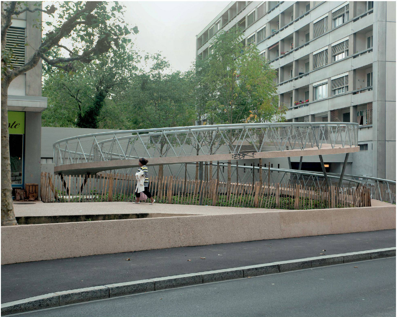
Betonmauern schaffen präzise Abgrenzungen, und die neue Spiralrampe vermittelt zur Dachterrasse der Cité Jonction.
