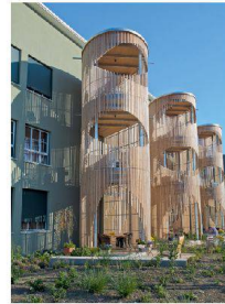
Umnutzung Fabrik Fornasone in Wohnungen, Volketswil ZH Burkhalter Sumi
