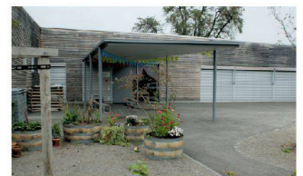
Aussenraum Wohnheim Pigna, Kloten ZH Rotzler Krebs Partner
