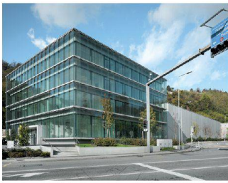
Glaskopf und Betonkörper liegen direkt an der Strasse. Foto: Roger Frei
