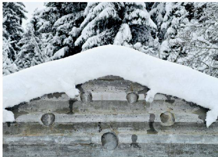
Als Abguss eines ruinösen Strickbaus hält der Neubau die Erinnerung an das Alte wach.
