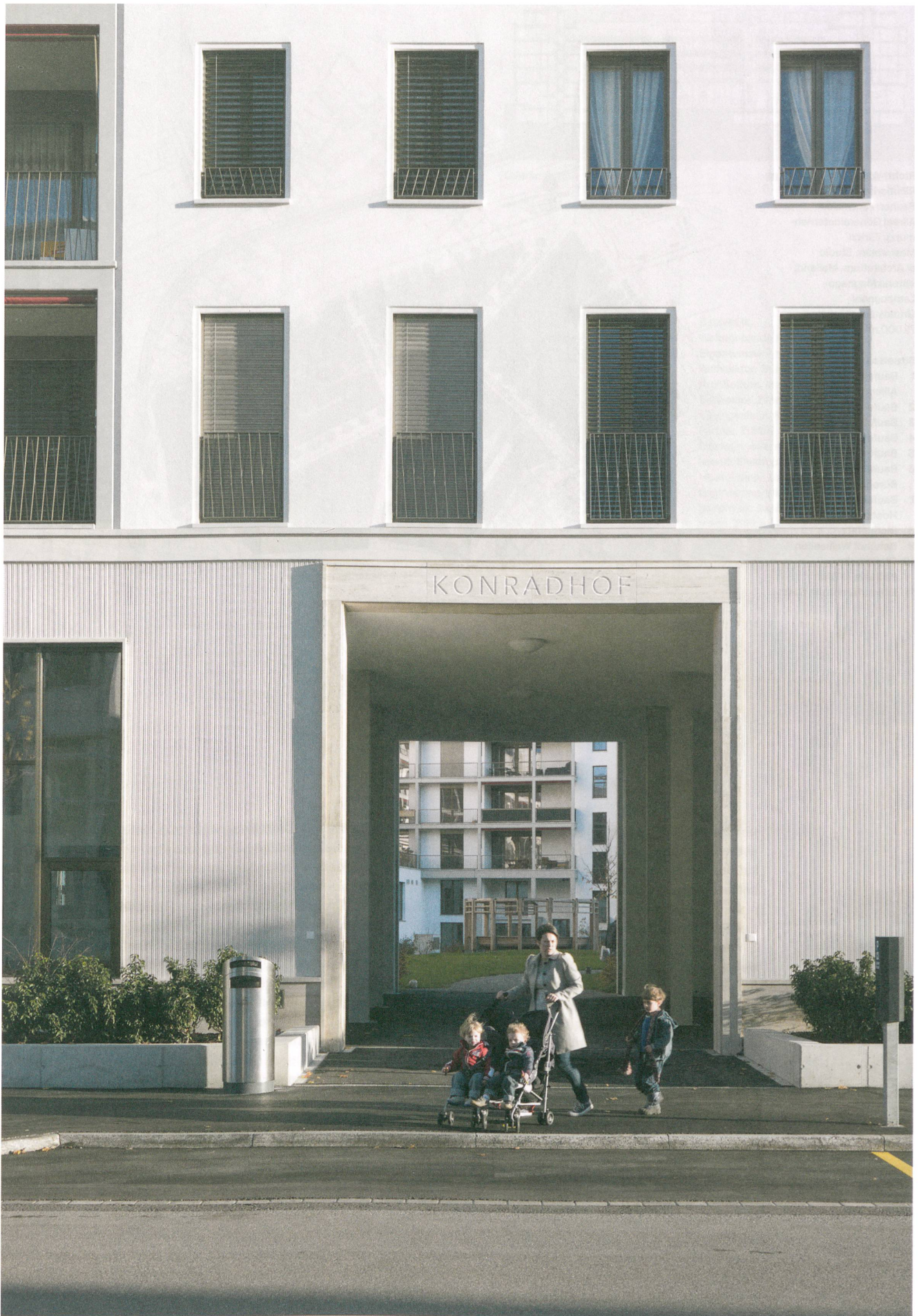
Agglomeration ohne Abstandsgrün: Lampugnani Gebäude in Wallisellen steht mit Sockel gefasst an der Strasse, kleine Vorgärten filtern den Blick in die Wohnungen.
