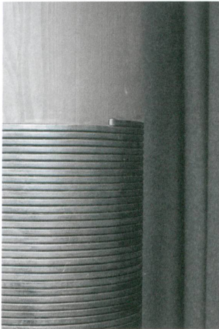
Ausgefeilt: Lederband schützt die Säulen.
