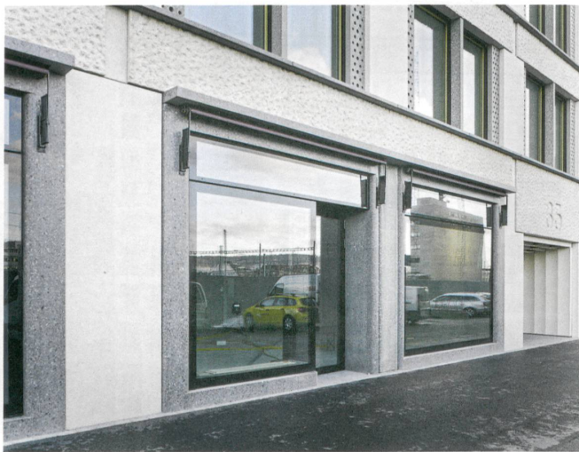
Schaufenster: Das Glas fließt bis zum Rand, der Beton rundet sich sinnlich, der Kunde ist König.
