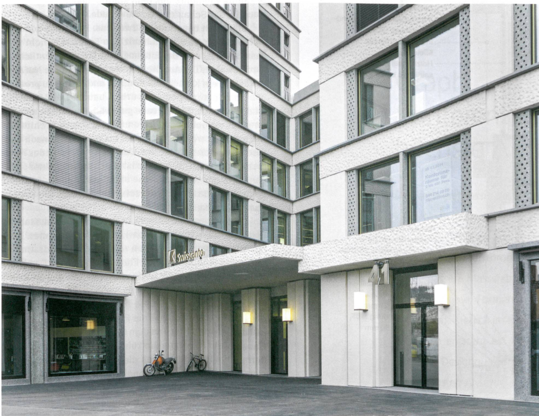
Eingang Büros: Das Vordach inszeniert die Hauptmieterin Swisscanto, zu den anderen Firmen gehts durch die separate Tür rechts davon.
