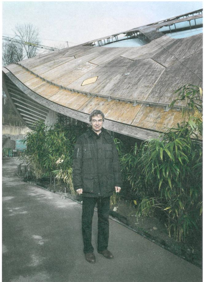
Der Bauingenieur Carlo Galmarini und die Pièce de Résistance: Der Ringbalken der Dachschaale ist auf 200 Tonnen Zug vorgespannt.
