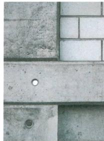
Das Tragwerk aus Ortbeton ist teils mit Kalksandsteinmauerwerk ausgefacht.
