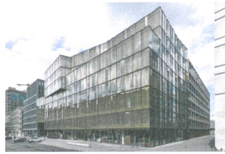
Bürobau für die Bank UBS auf dem Baufeld C. Architektur: Gigon / Guyer (u. a.). | Kantoorbouw voor UBS op bouwterrein C. Architectuur: Gigon / Guyer (e. a.)
