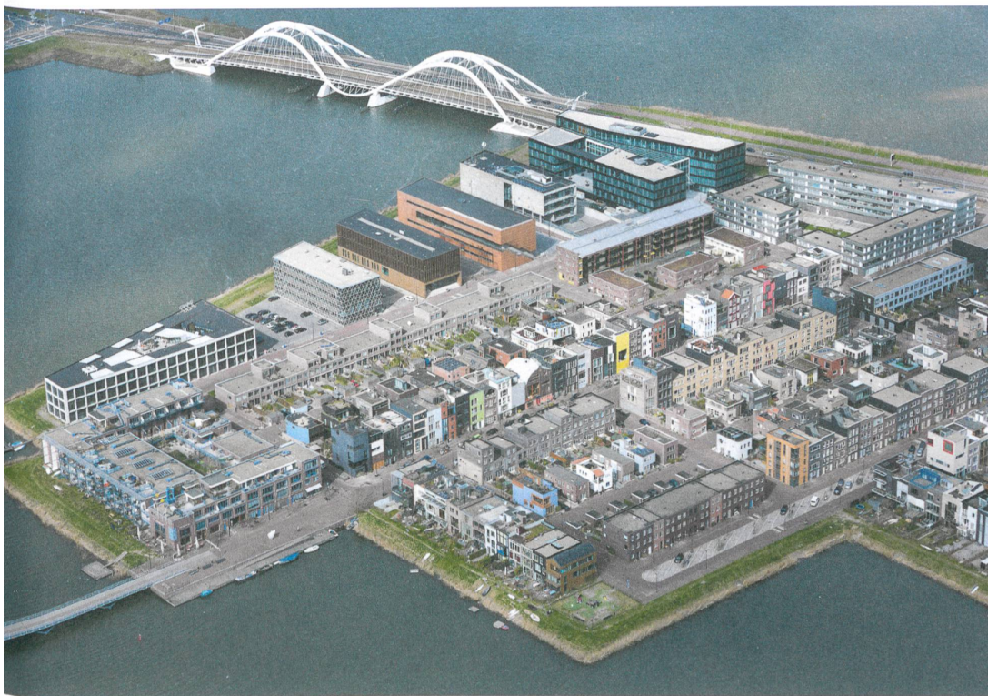
Uniforme stedenbouw, veelsoortige architectuur: omgevingsbeeld van het haveneiland. | Einheitlicher Städtebau, vielfältige Architektur: Szenerie auf Haveneiland.
