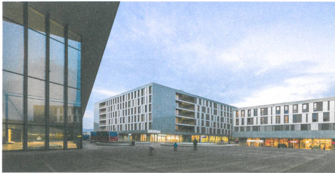
Zwei unterschiedliche Bauten, die zusammengehören: das Quartier Nord der EPFL.
