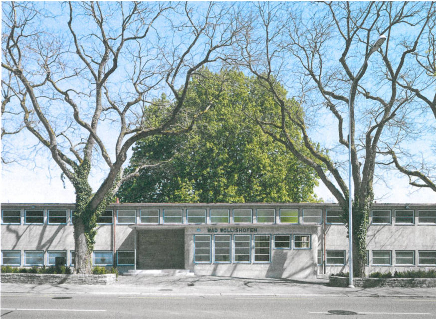
Das aufgefrischte Strandbad Wollishofen in Zürich ist strassenseitig streng gegliedert.
