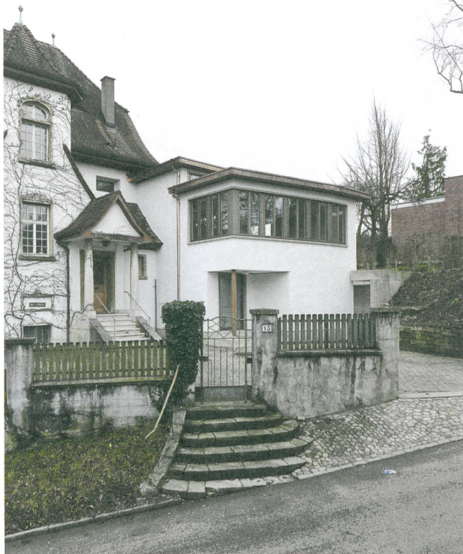
Der Holzanbau in Liestal nutzt das Fundament der abgerissenen Garage.
