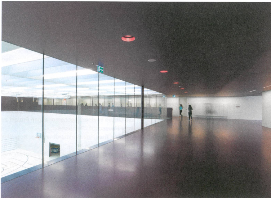
Schwere Decke, helle Wand: Die Turnhalle wirkt als Leuchtkörper, der den Flur der Schule belichtet. Foto: Eik Frenzel
