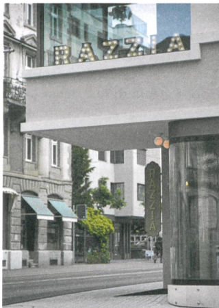
Der Neubau ragt mit einem Erker in die Seefeldstrasse.
