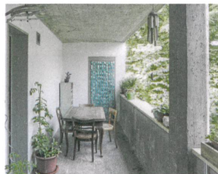
Über die idyllische Betonlaube betritt man die oberen Wohnungen.
