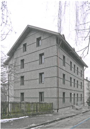
Der Umbau gab dem Haus im Berner Lorrainequartier ein neues Gesicht.
