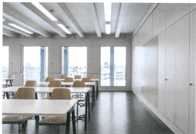
Die Decke der Klassenzimmer zeigt die Tragstruktur, die sich mit den äusseren Stützen verbindet.
