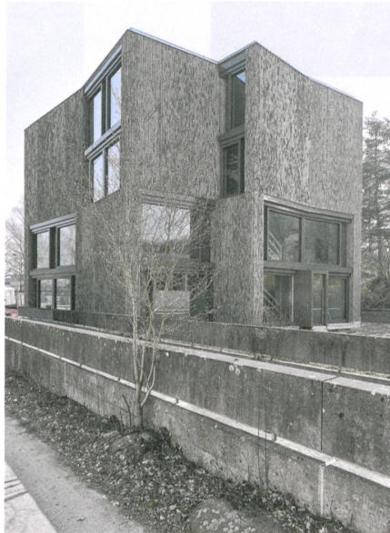
Der Erweiterungsbau des Schulhauses Kopfholz in Adliswil ist leicht geknickt. Zweigeschossige Fassadenelemente und Fensterpartien wechseln sich ab.
