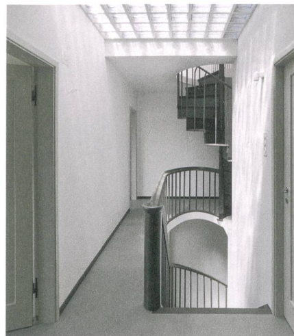
Der spannendste Raum des Hauses: Die von oben belichtete Treppe geht in eine Spindelterrasse über.
