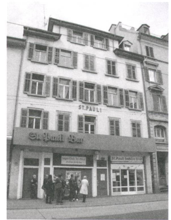
Das Haus von 1892 vor dem Umbau.
