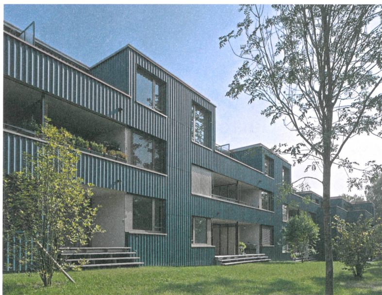
Geschickt fängt das Gebäude an der Dollikerstrasse in Meilen das Gefälle des Geländes auf.
