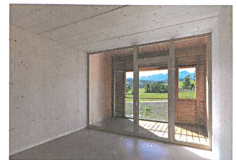
18 Die Holzfassade prägt auch die Innenräume. | The wooden façade also characterises the inside.
