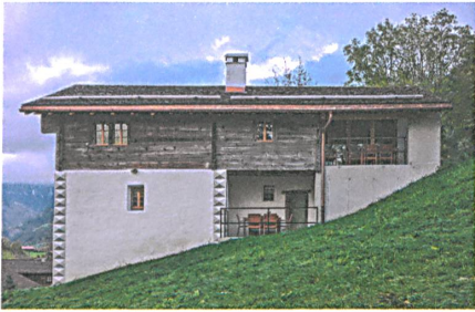
10 Altes Holz und neuer Beton. | Old wood and new concrete.
