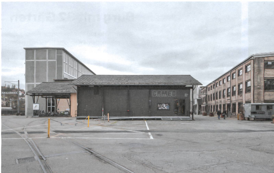
Unter einem alten Dach auf dem Lagerplatz-Areal in Winterthur steht ein neues Kino.
